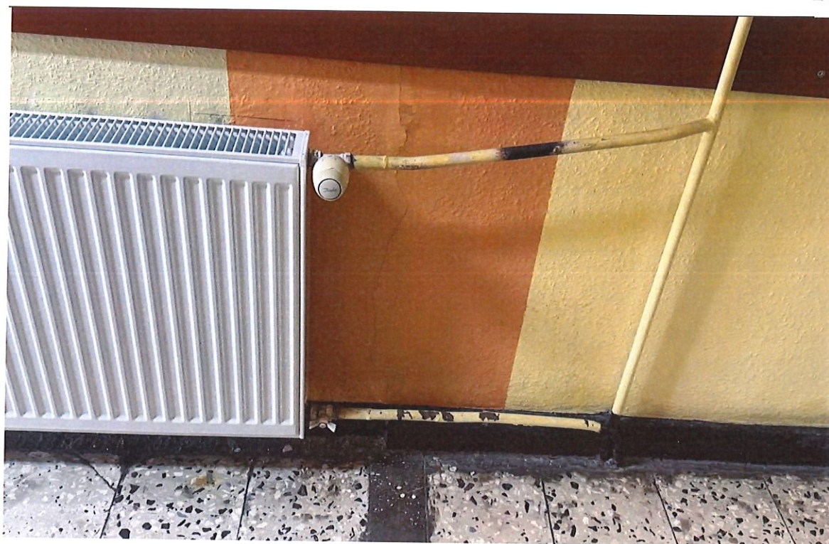
Grzejnik stalowy, płytowy w układzie grzewczym budynku.
