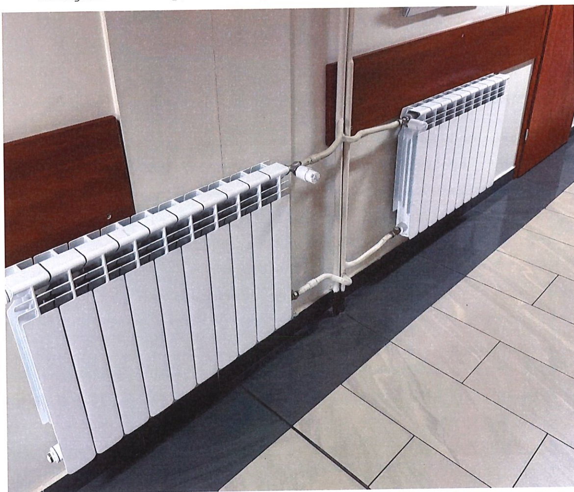
Grzejnik żeliwny, członowy w układzie grzewczym budynku.
